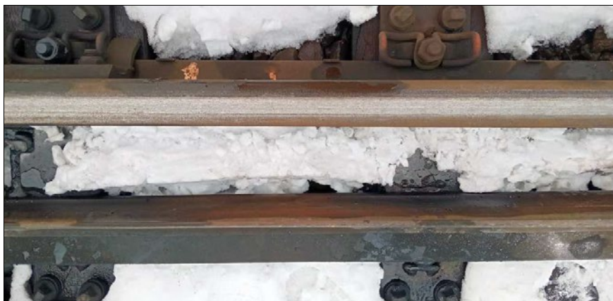
Fot. 31. Rozjazd nr 39 referencyjny, strefa A, moc grzejników 100%, stan po 28 minutach grzania. WYŁĄCZENIE grzania.
