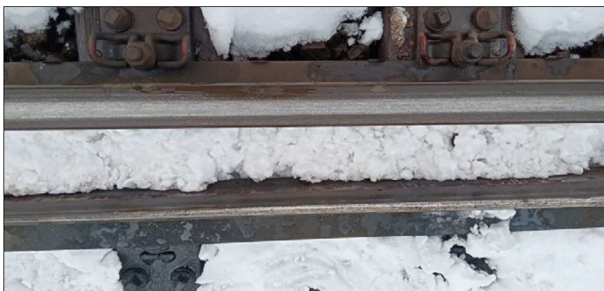
Fot. 37. Rozjazd nr 39 referencyjny, strefa B, moc grzejników 100%, stan zaśnieżenia przed rozpoczęciem grzania.
