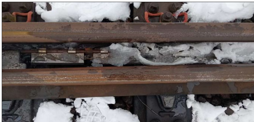
Fot. 38. Rozjazd nr 38 z radiatorami, strefa B, stan po 15 minutach grzania. Moc grzejników 100% .
