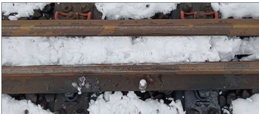
Fot. 27. Rozjazd referencyjny nr 39 referencyjny, strefa A, moc grzejników 100%, stan zaśnieżenia przed rozpoczęciem grzania.
