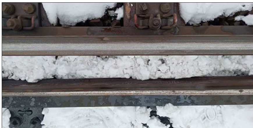
Fot. 39. Rozjazd nr 39 referencyjny, strefa B, stan po 15 minutach grzania. Moc grzejników 100% .
