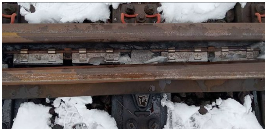
Fot. 40. Rozjazd nr 38 z radiatorami, strefa B, stan po 27 minutach grzania. Moc grzejników 100%.
