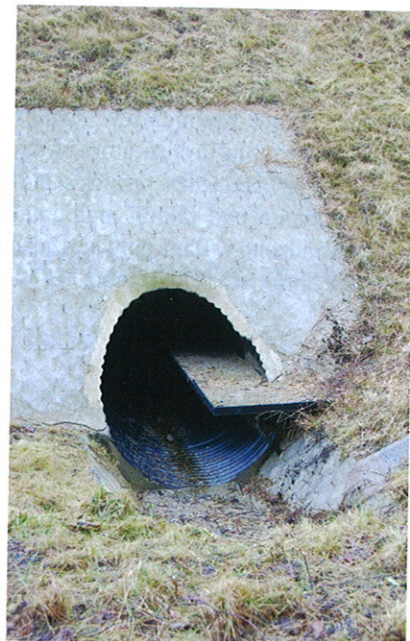
Przejście dla małych zwierząt – przepust z suchą półką
