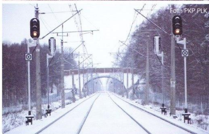
Przejścia dla zwierząt w Rzepinie
