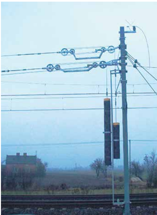
Fot. 1. Ciężarowe urządzenie naprężające
