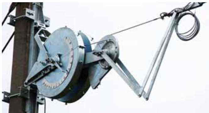
Fot. 3. Sprężynowe urządzenie naprężające produkcji firmy Mabo Sp. z o.o.
