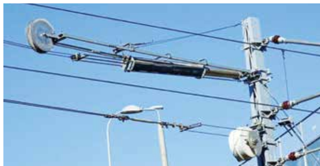
Fot. 2. Sprężynowe urządzenia naprężające: ze sprężyną śrubową – górne, ze sprężyną spiralną – dolne [4]
