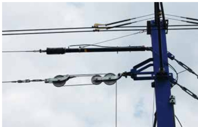
Fot. 4. Gazowe urządzenie naprężające produkcji firmy Galland (górne)
